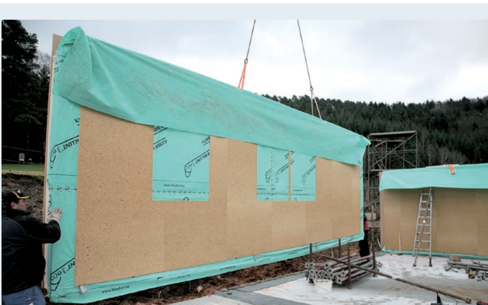
Die Holztafeln werden auf der Baustelle montiert. Sie übernehmen sowohl statische wie auch bauphysikalische Aufgaben.
